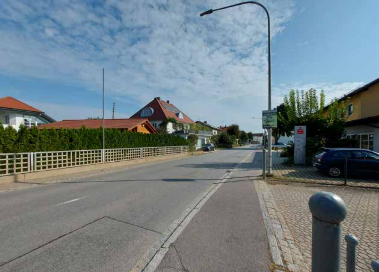
Landshuter Straße auf Höhe Sparkasse, Oberflächengestaltung differenziert, insgesamt wenig Aufenthaltsqualität für Fußgänger und Radfahrer, Nebenflächen an vielen Stellen knapp bemessen - nicht im Sinne der Barrierefreiheit.
