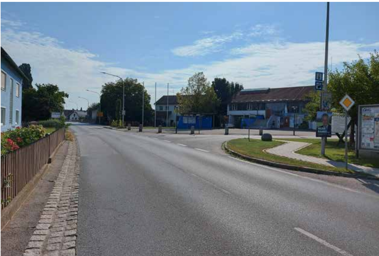
Blick in die Landshuter Straße, rechts Rathaus und Rathausvorplatz - dominierend ist die lineare Entwicklung der Straße, wenig Raum für Fußgänger und Radfahrer.
