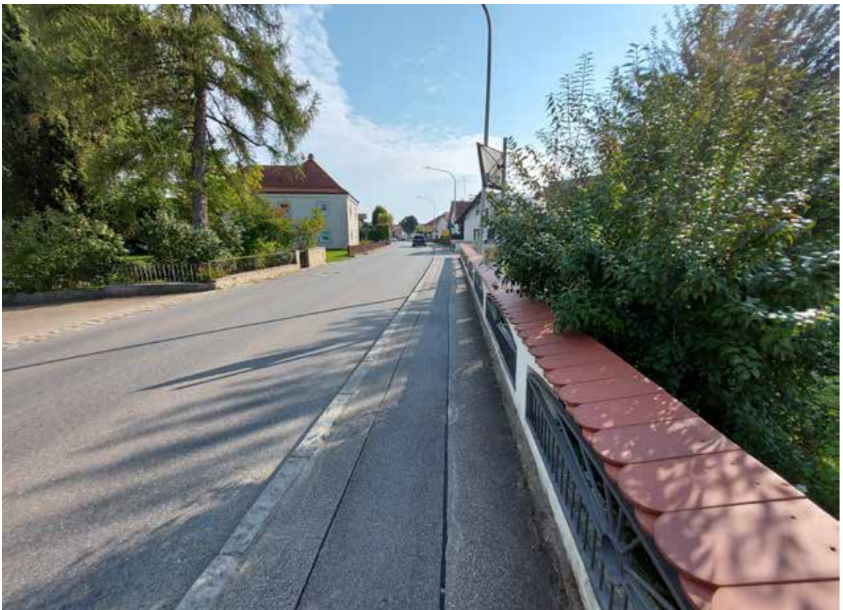
Straubinger Straße / Landshuter Straße schmale Gehwegsituationen
