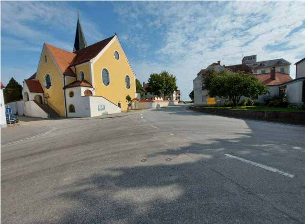
Umfeld Kirche mit Friedhofsmauer im Bildhintergrund
